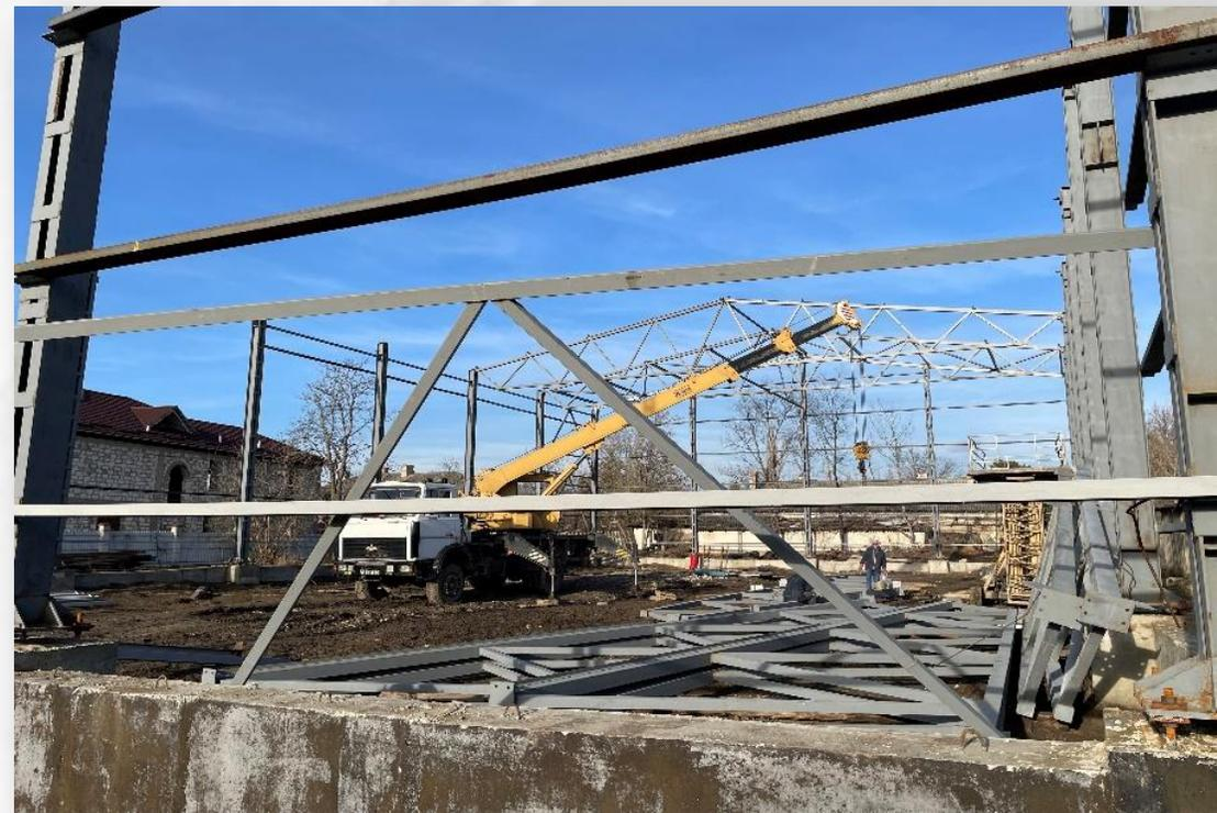
На территории провели снос всех строений, была выполнена вертикальная планировка площадки, заливка фундамента, монтаж каркаса здания.
